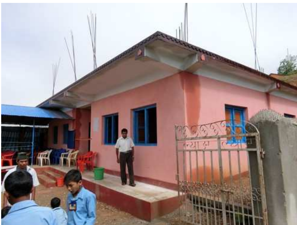
Un exemple d'une nouvelle construction d'école
