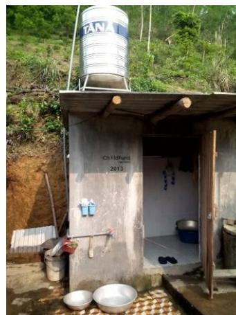
Nous avons eu la chance d'avoir bénéficié du projet et d'avoir reçu les matériaux nécessaires à la construction d'un bloc de douche en béton. Mon mari a reçu une formation pour la construction, et il a effectué les travaux en 2 jours. De plus, nous avons bénéficié d'un crédit pour acheter un réservoir destiné à stocker l'eau. Installé sur le toit, il nous permet de nous laver et d'avoir de l'eau pour notre consommation journalière.
