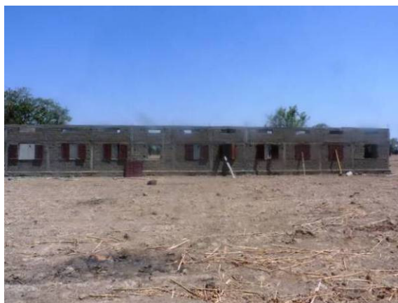
Construction de l'école
