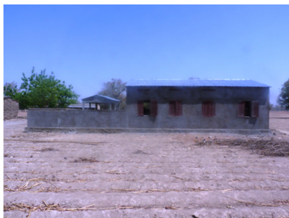
Construction de la CLEP
