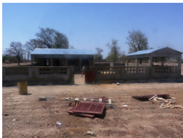
Construction de la CLEP
