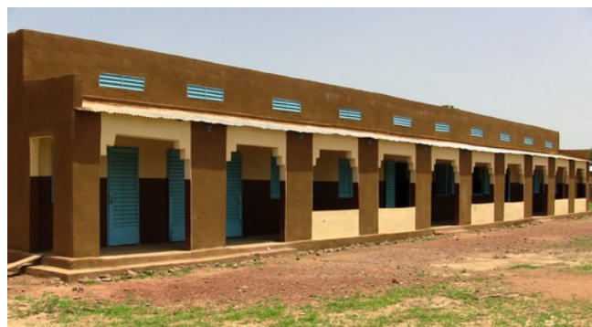
L'école de Necko terminée
