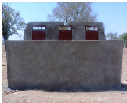
Construction des toilettes de l'école
