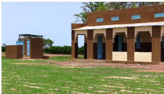
La nouvelle école primaire de Necko ; à gauche, les latrines
