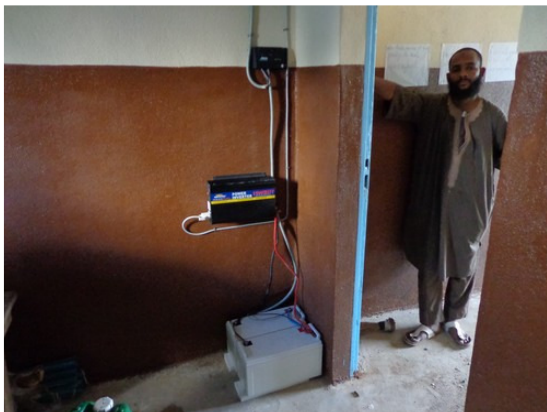
Salif, le technicien chargé de l'installation solaire
