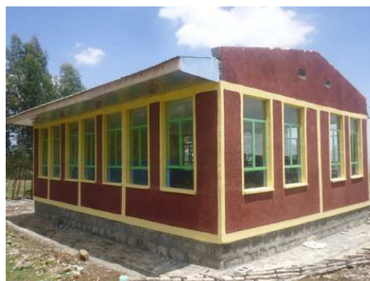
La bibliothèque de l'école d'Aba Mote terminée
