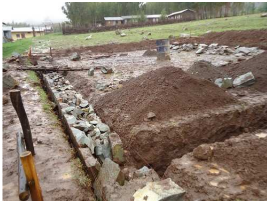
Construction des fondations
