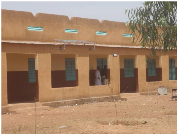
Les panneaux solaires ont été installés sur le toit
