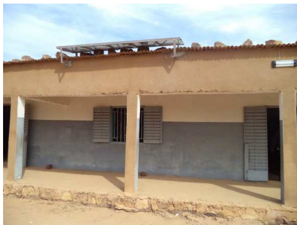
Les panneaux solaires ont été installés sur le toit (Fadiola)
