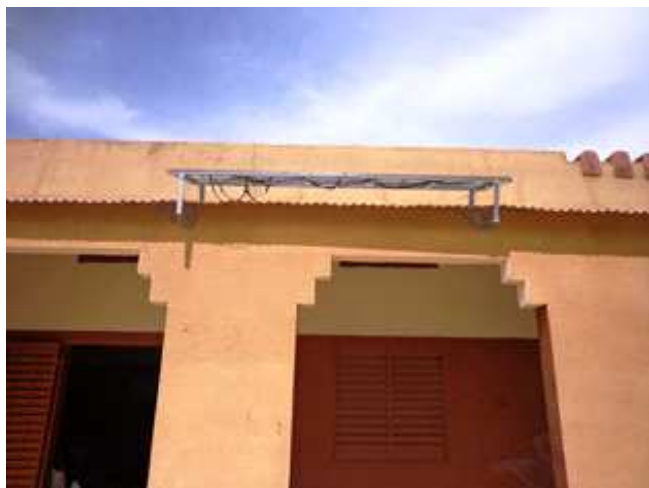
Les panneaux solaires ont été installés sur le toit (Blengoua)
