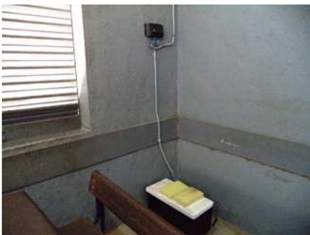
*Batterie et régulateur à l'intérieur d'une salle de classe*
