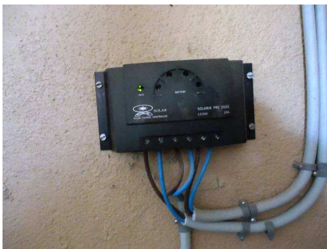
Le régulateur qui fournit l'énergie emmagasinée par le panneau solaire.
