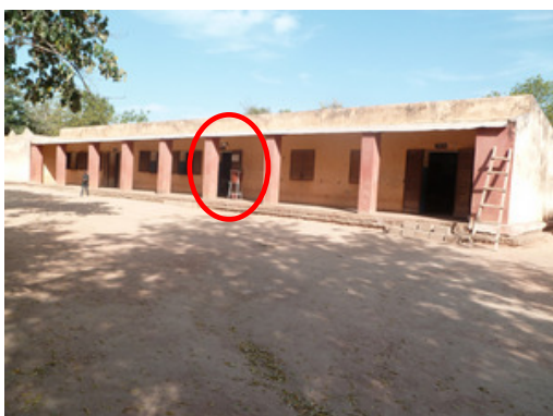
Installation d'une lampe à l'extérieur de l'école de Kéréla
