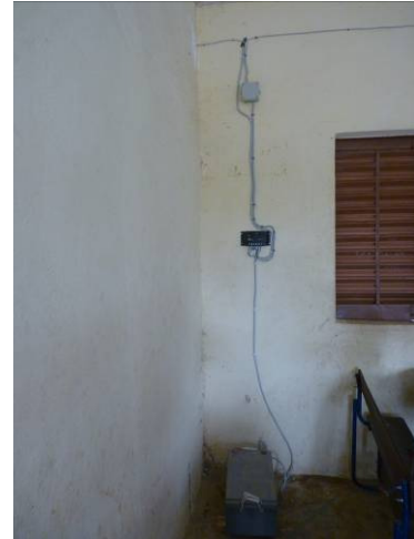
Le régulateur qui fournit l'énergie emmagasinée par le panneau solaire.
