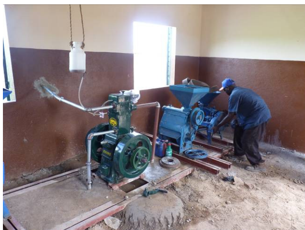
Installation du moulin
