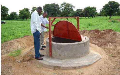
Les équipes de BØRNEfonden Mali entrain de vérifier les installations
