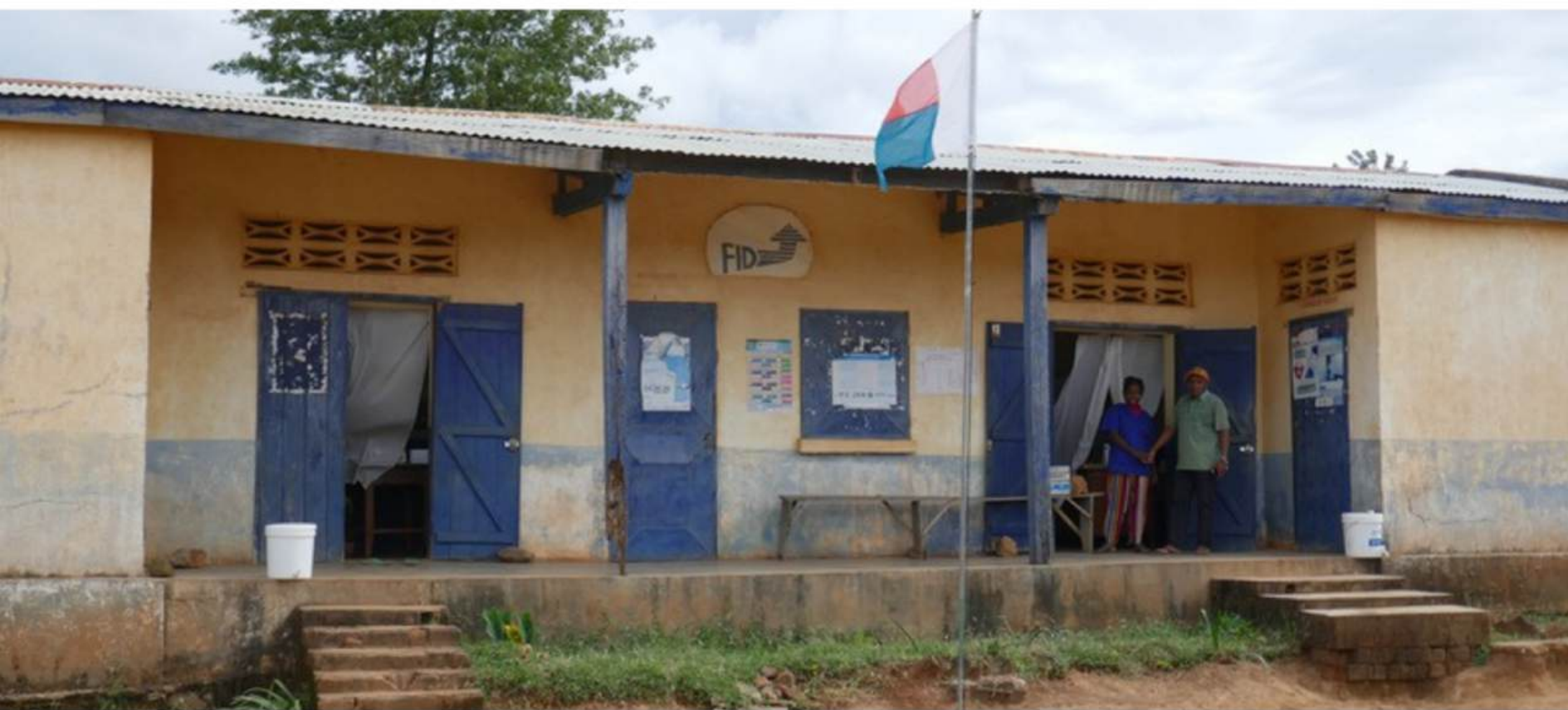
Ancien centre de santé (2022)
