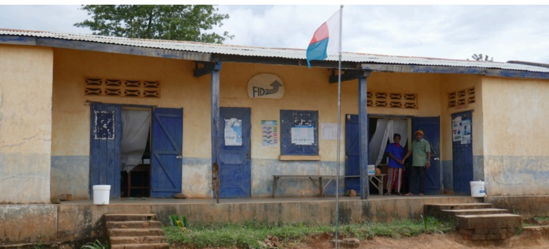
Ancien centre de santé (2022)
