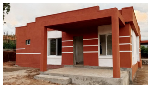
Chantier de construction du centre de santé
