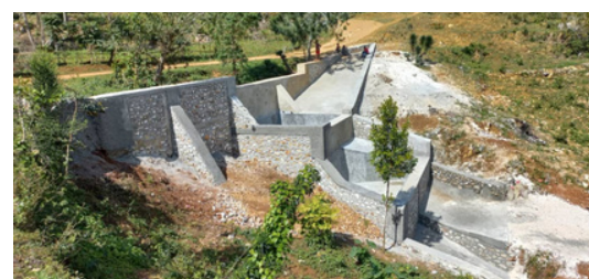
Bassins construits en aval des seuils permettant de stocker de l'eau
