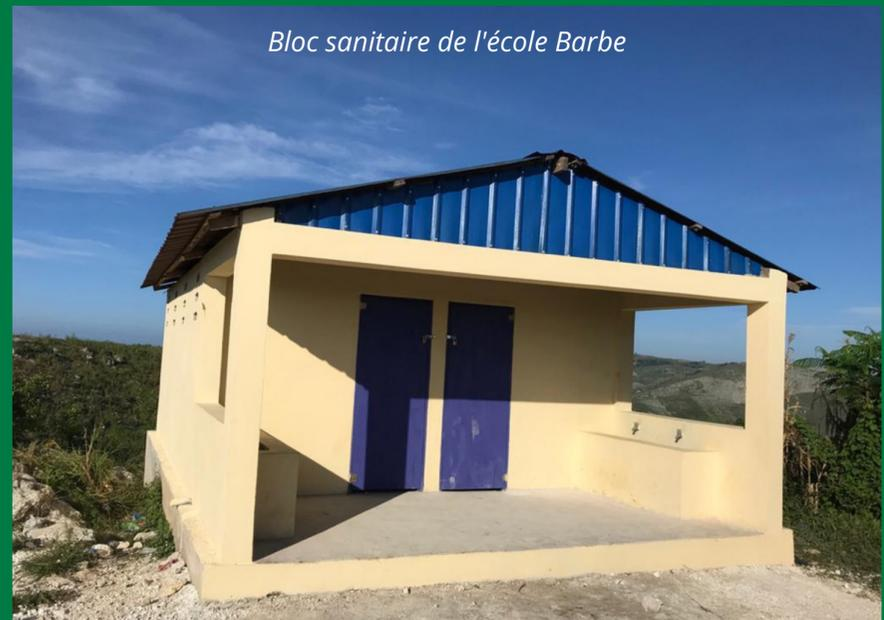
Chaque bloc sanitaire est constitué de **6 latrines individuelles** et fermées par une porte afin de garantir l'intimité des élèves et personnels de l'école, de **2 urinoirs** et d'un **dispositif de lavage des mains** afin de **limiter la propagation de maladies d'origine hydrique** et ainsi **réduire l'absentéisme scolaire.**
