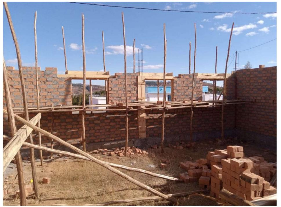
*Élévation du mur et élevage en superstructure*
