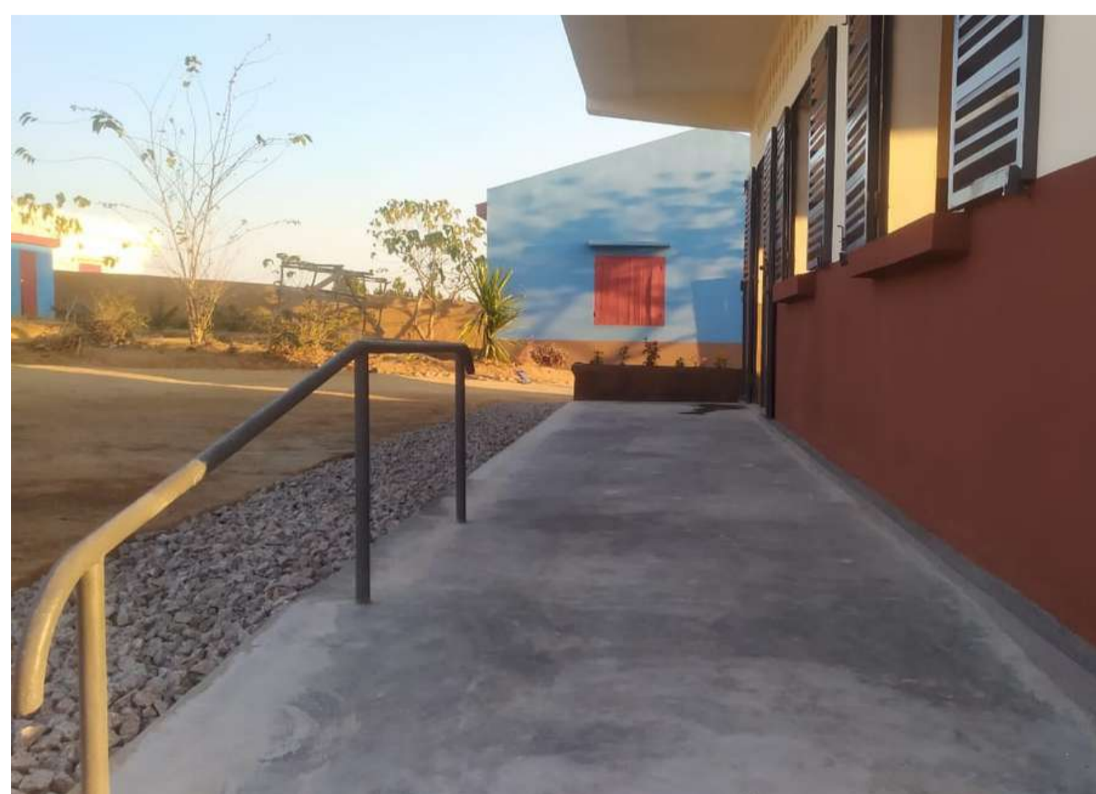
Rampe d'accès pour les personnes à mobilité réduite dans la salle de classe construite en 2021
