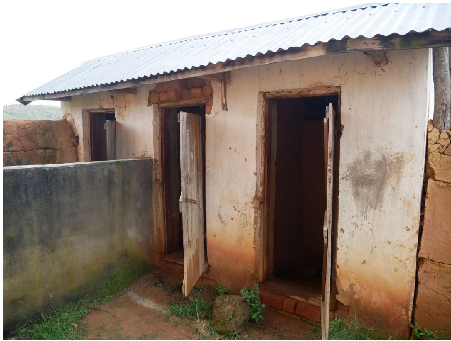
Etat actuel des blocs sanitaires de l'école Antaninandro
