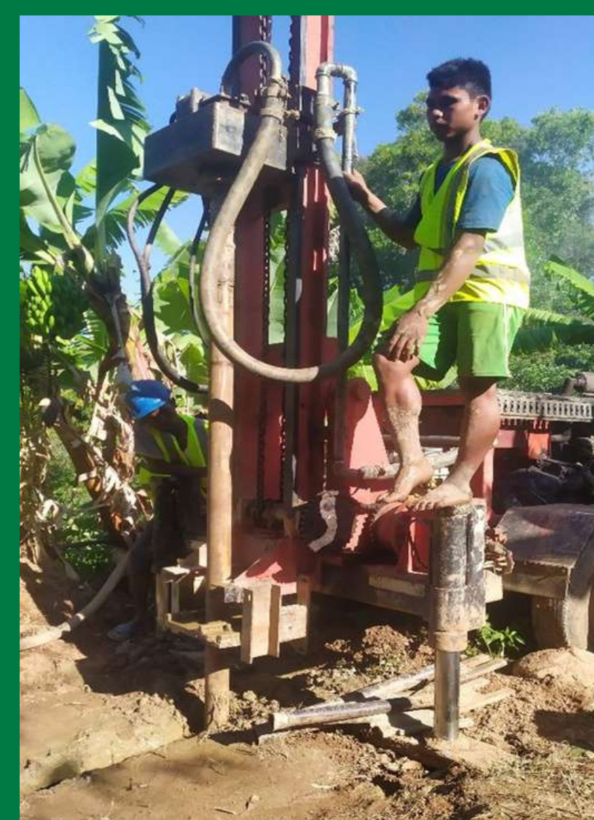
Forage d'un puits
