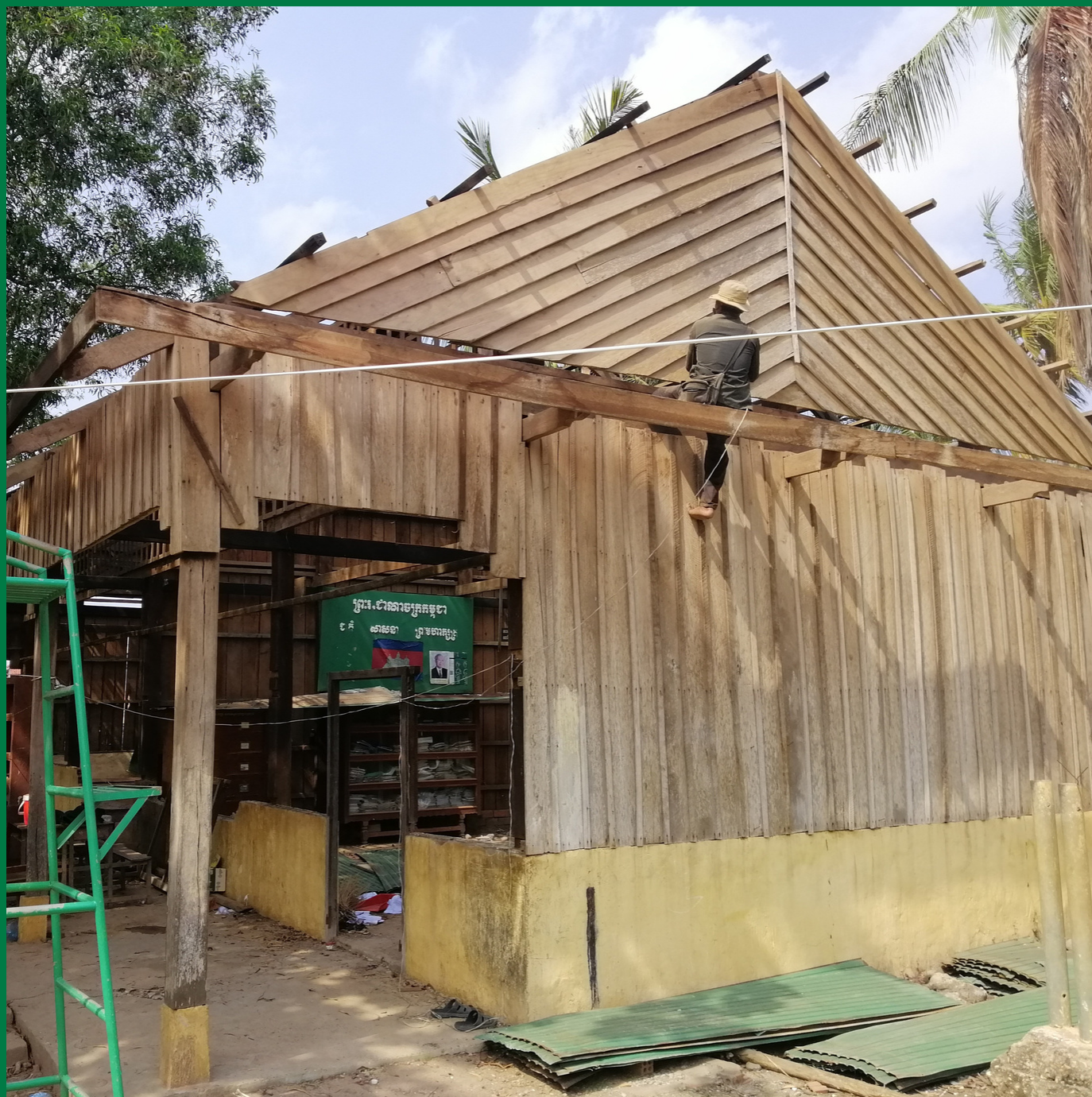
Rénovation d'une façade en cours
