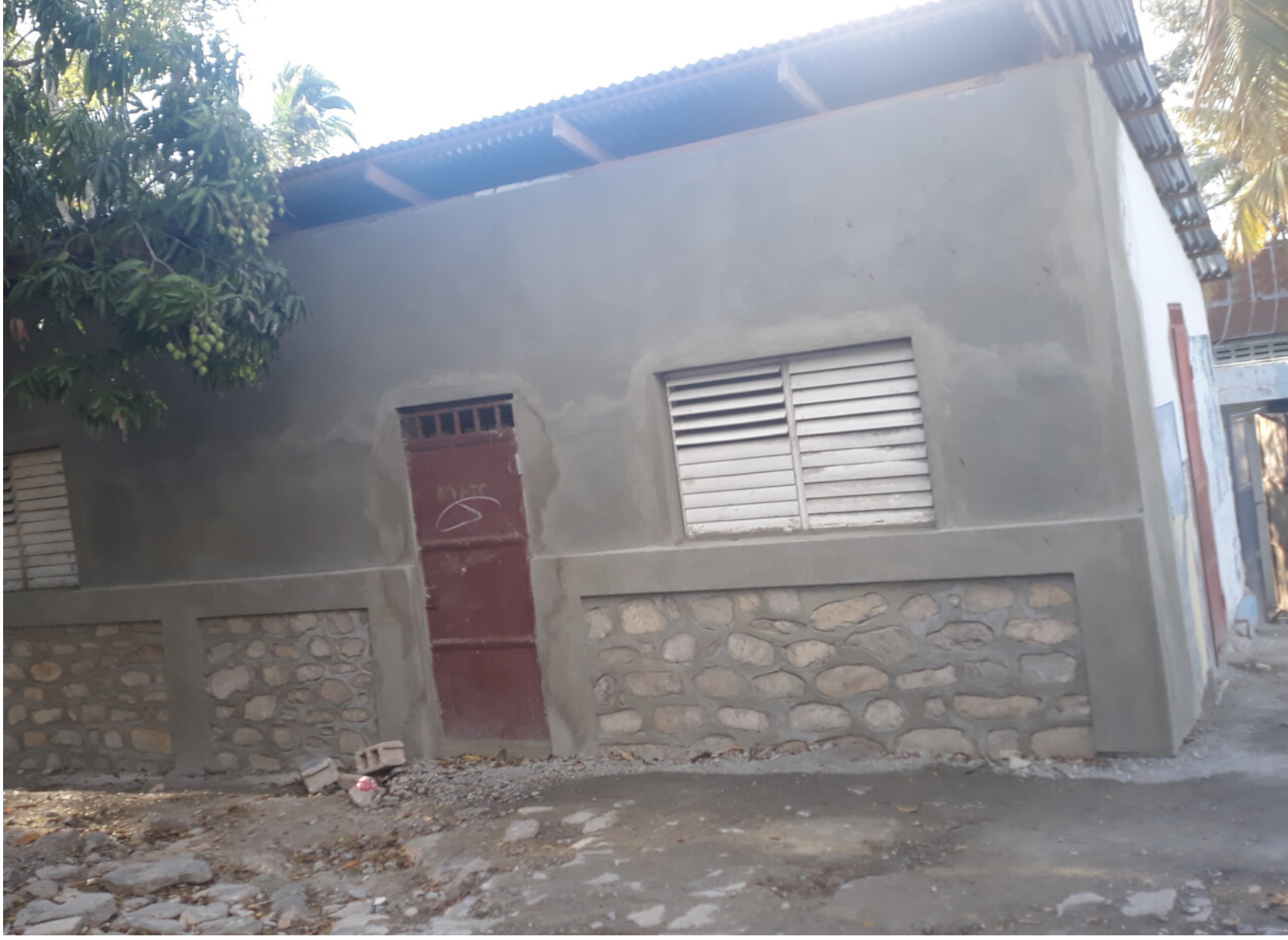
Vue extérieure de la salle informatique réhabilitée
