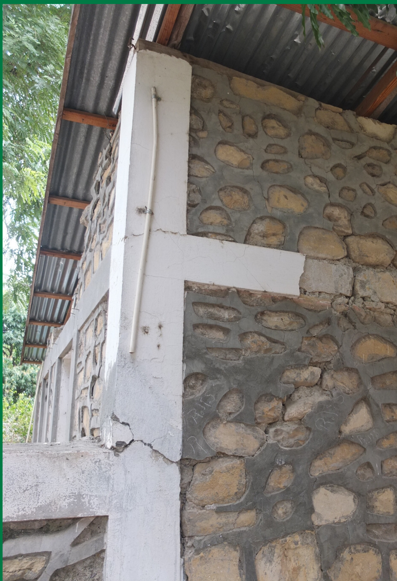
Colonne extérieure de la salle informatique, dont les fissures et l'absence d'armature métallique en ceinture du bâtiment rendaient possible l'effondrement de la salle en cas de nouvelles secousses
