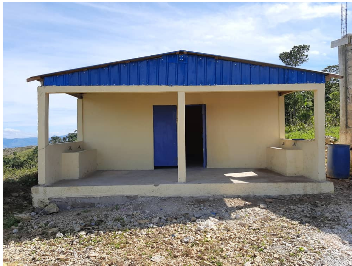
Bloc sanitaire finalisé
