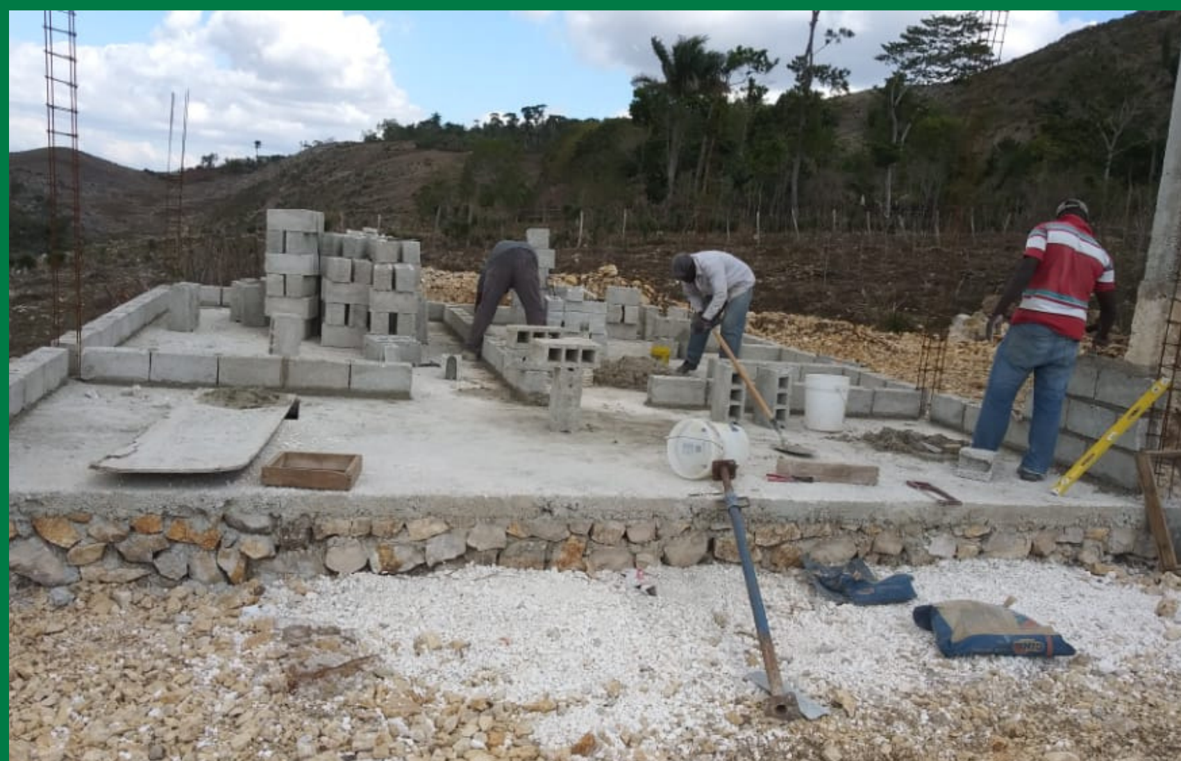
Equipe d'ouvriers au début du chantier
