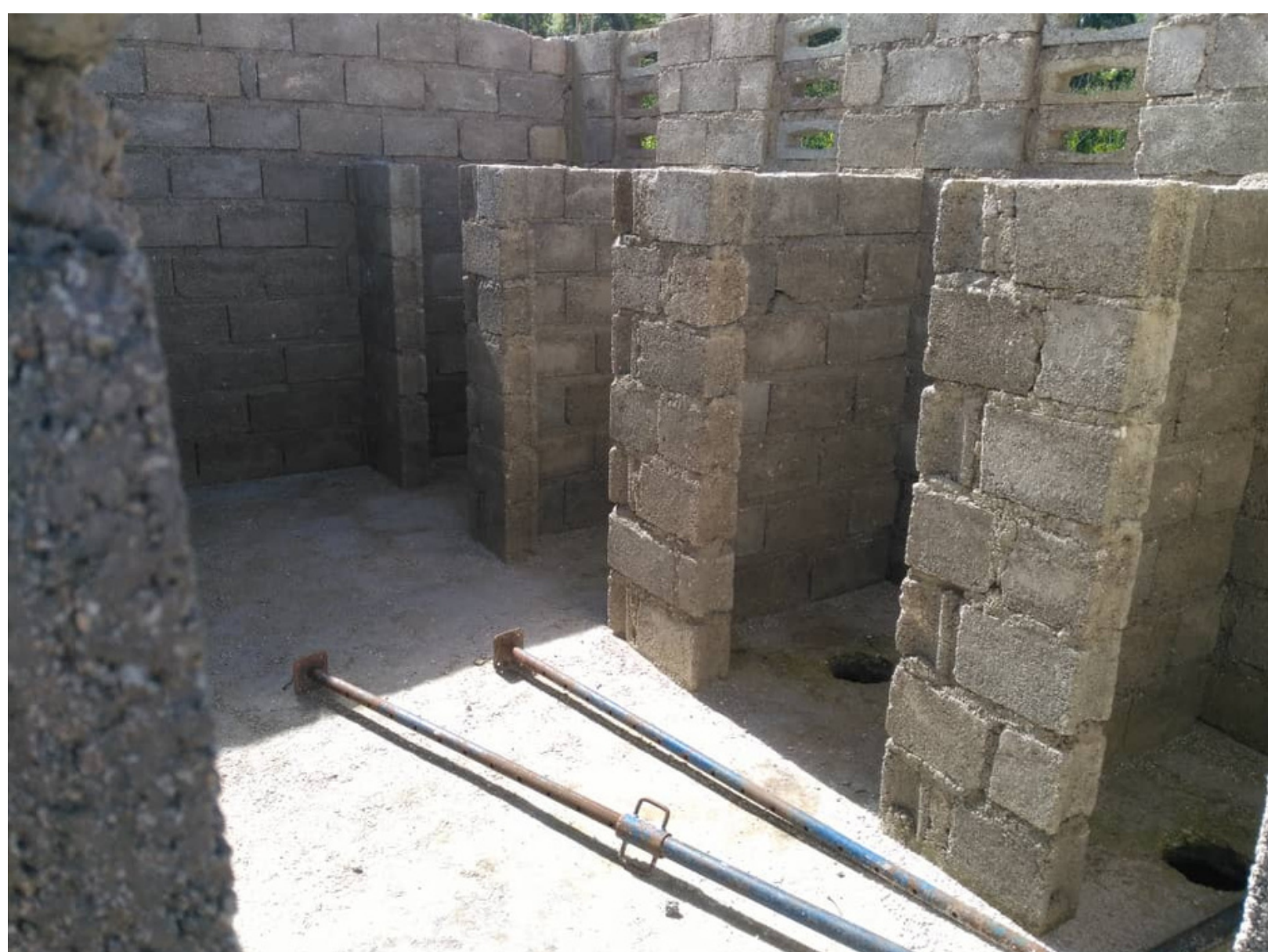
Vue intérieure du bloc sanitaire composé de 8 latrines
