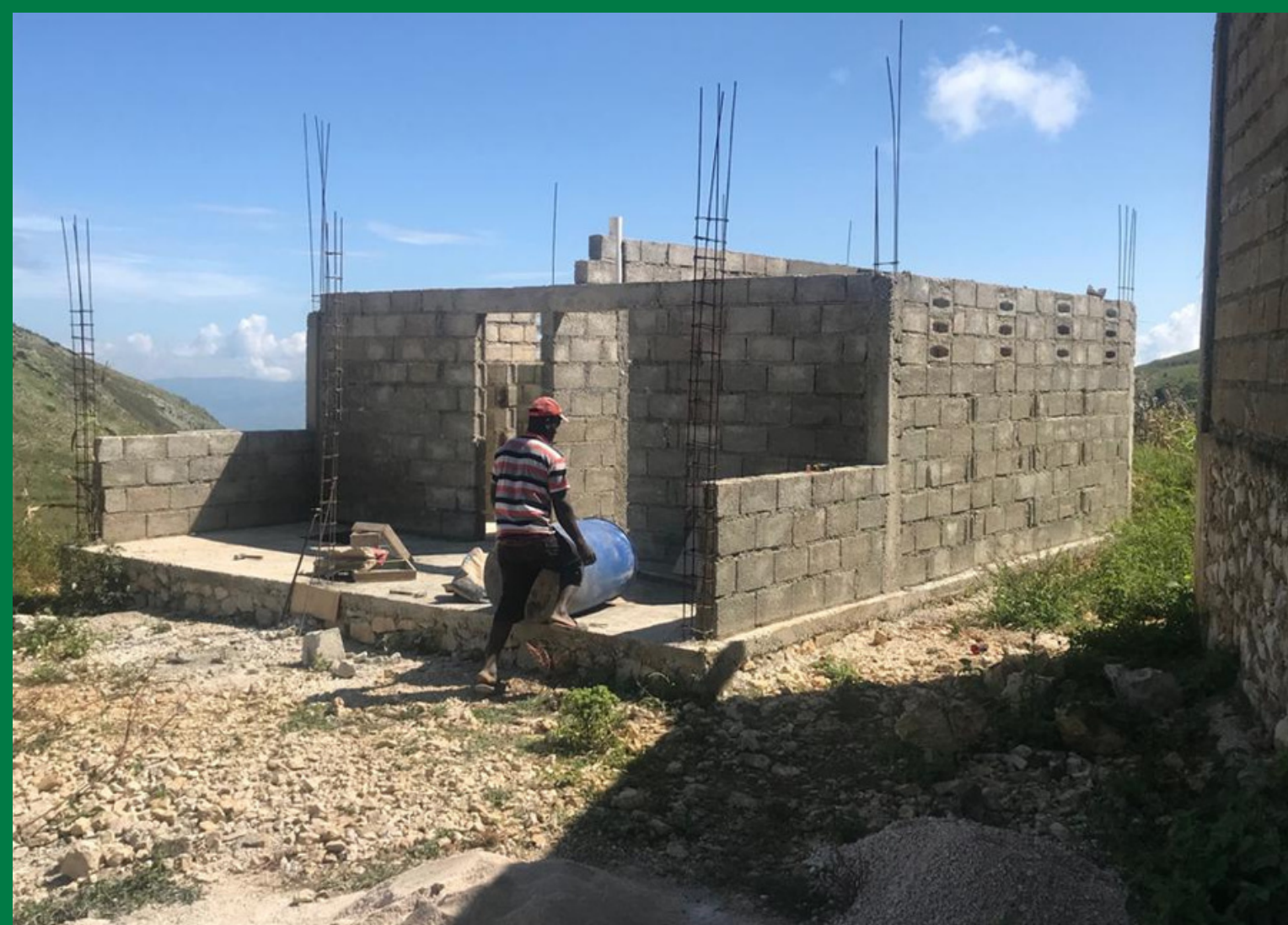
Construction des murs avec des blocs de parpaings
