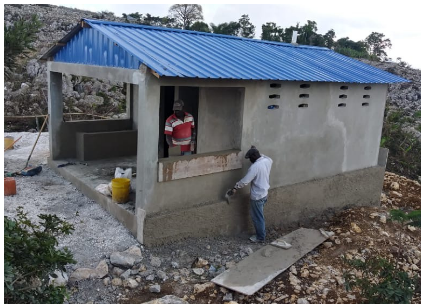
Vue extérieure du bloc sanitaire
