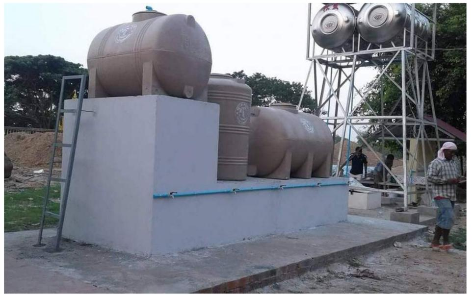
*Systeme de filtration BioSand installé dans une école, composé des trois réservoirs.*
