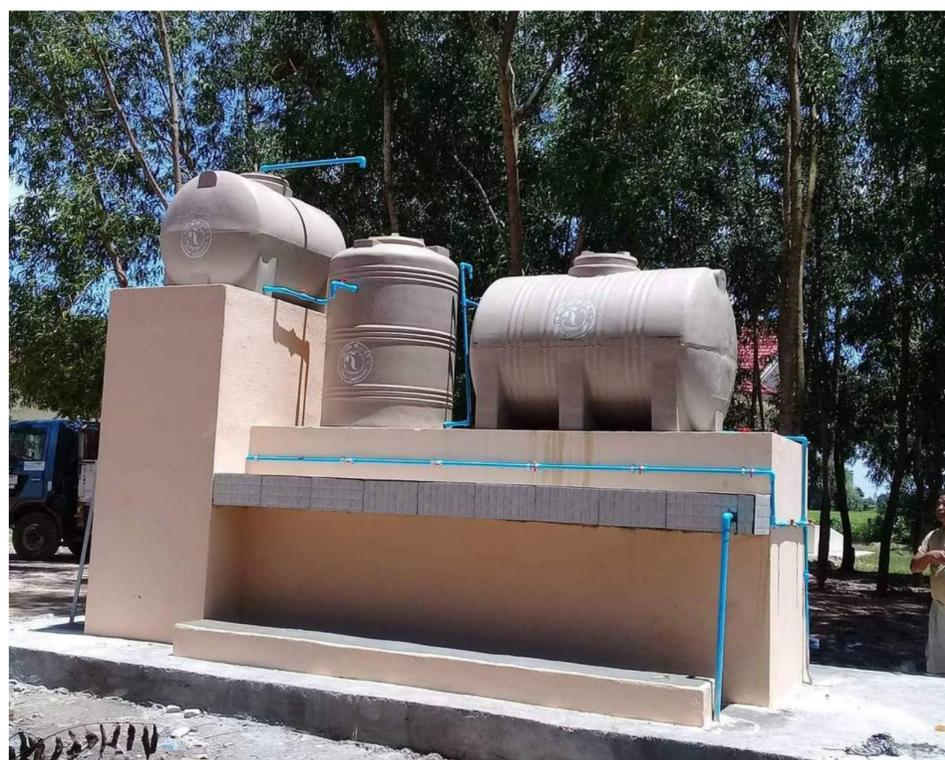
Ce système dispose de trois réservoirs aux fonctions différentes. Le premier collecte l'eau "brute" auprès des sources d'eau (souterraine ou étang, rivières...); il peut stocker 1000 litres. Le second est rempli de sable bio pour filtrer l'eau. Et le dernier est utilisé pour stocker l'eau filtrée devenue potable. Il relié aux installations telles que des robinets pour boire et peut produire 3 litres d'eau par minute.
