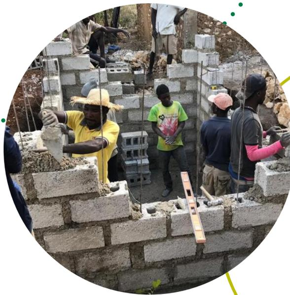
Identification de 11 emplacements et construction de 6 citernes familiales en maçonnerie d'une capacité de 12 m<sup>3</sup>, facilitant l'accès à l'eau des familles de la zone
