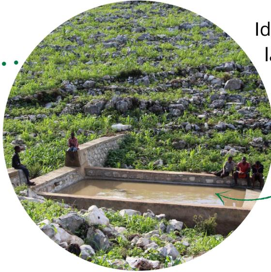
Identification de 2 emplacements pour la construction de 2 seuils bassins et démarrage de la fouille pour la construction d'1 seuil bassin
