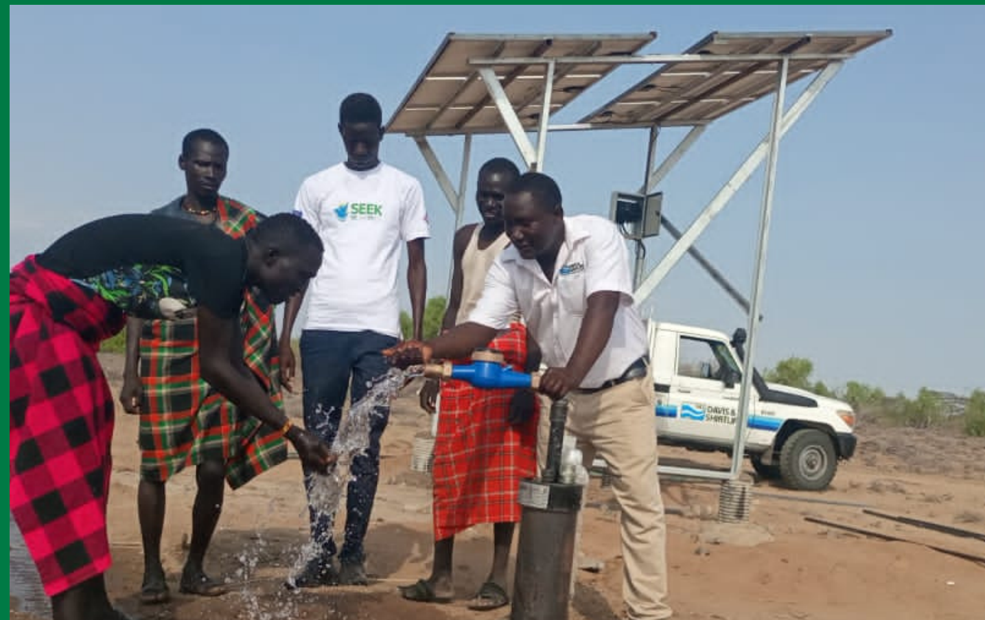
Puits équipé d'un kit photovoltaïque
