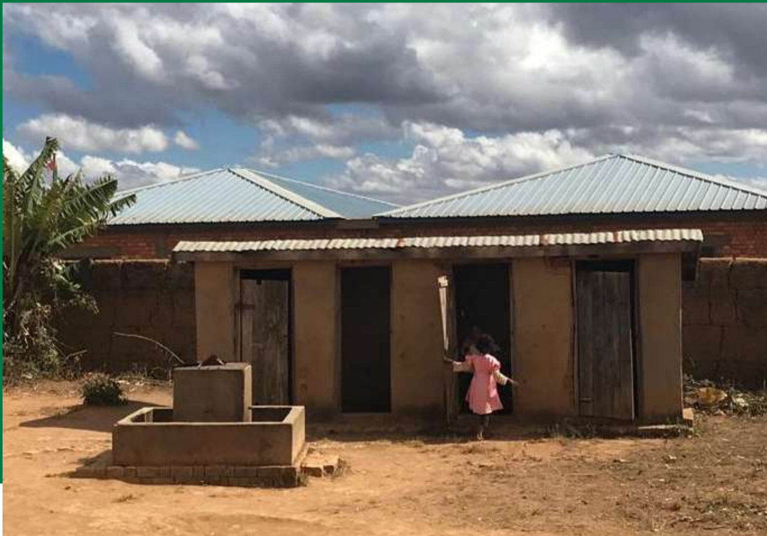
ANCIEN BLOC SANITAIRE
