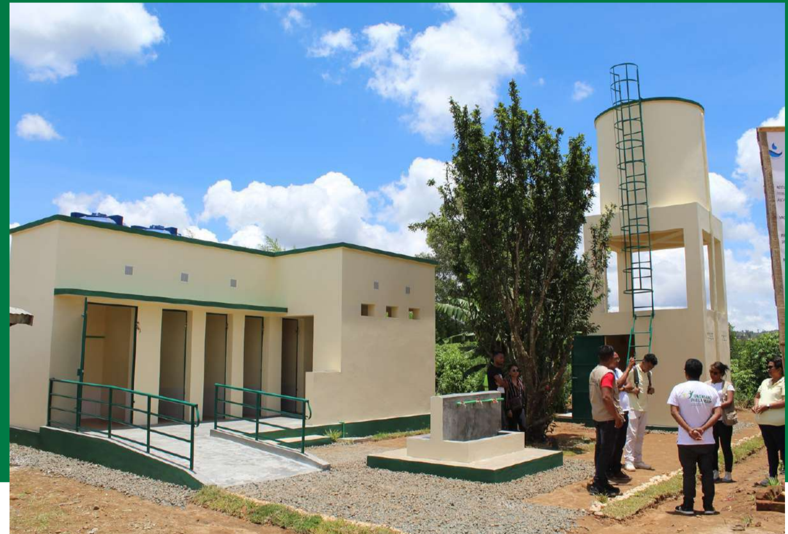
NOUVEAU BLOC SANITAIRE
