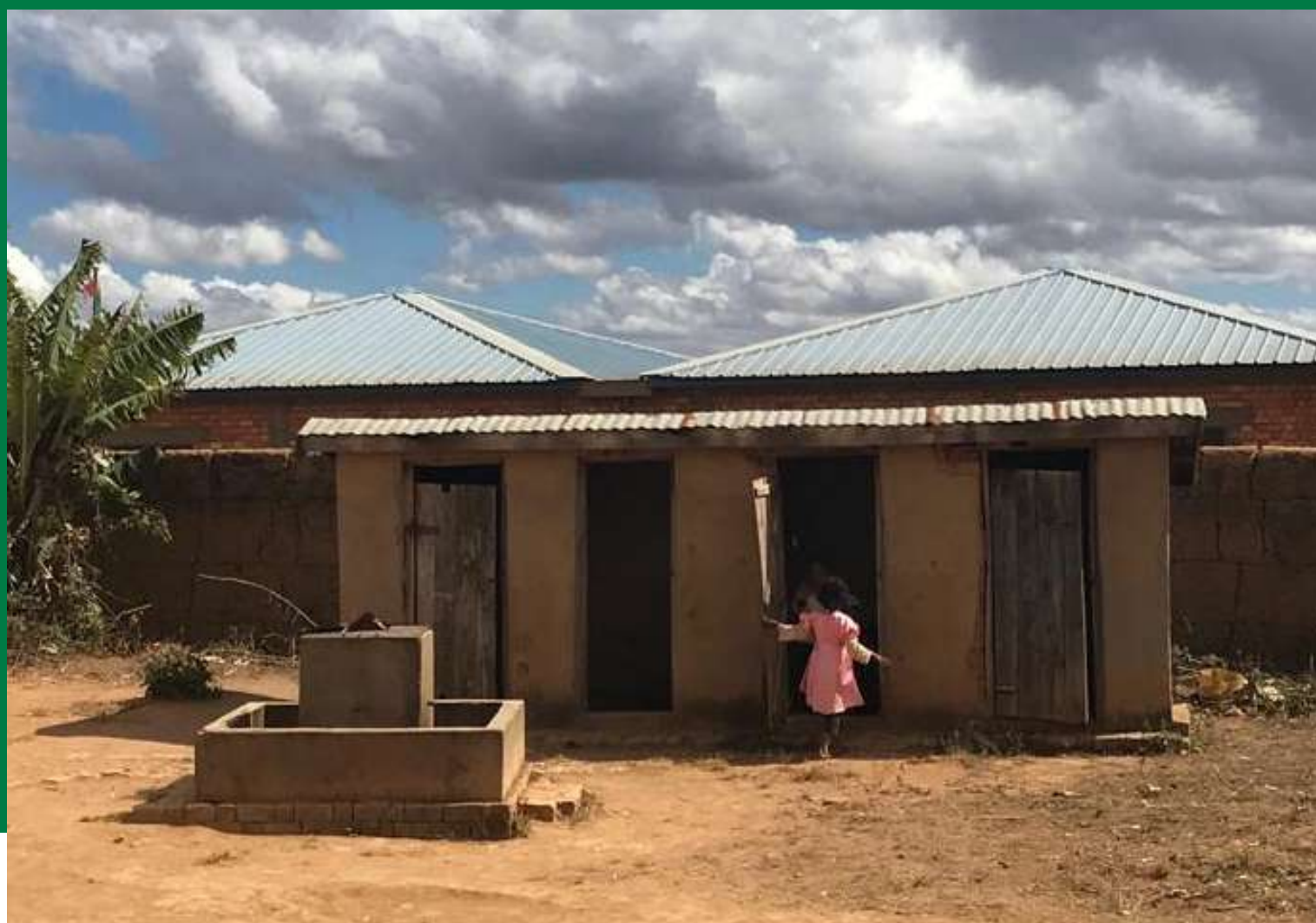
ANCIEN BLOC SANITAIRE
