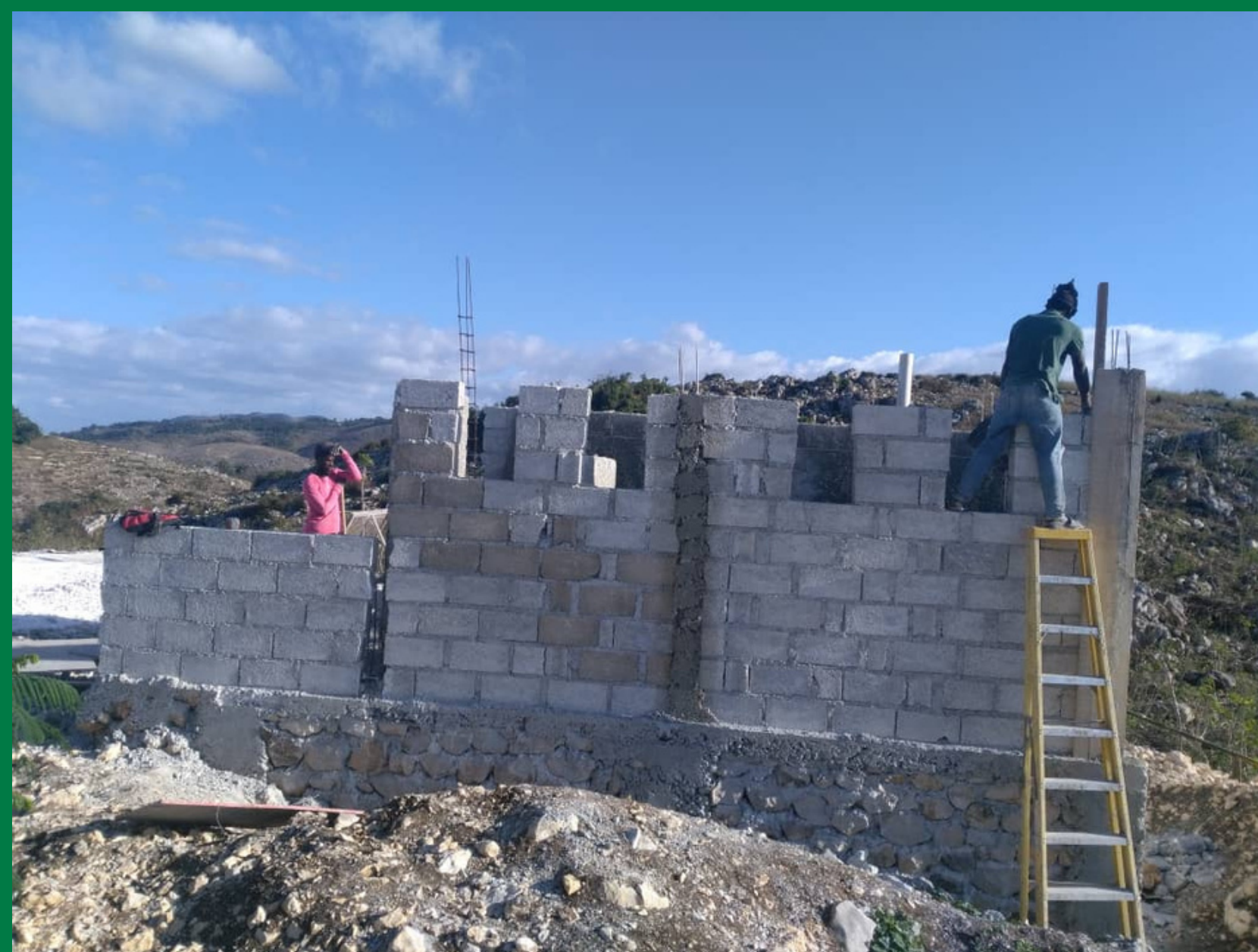
Construction des murs du bloc sanitaire avec des blocs de parpaings
