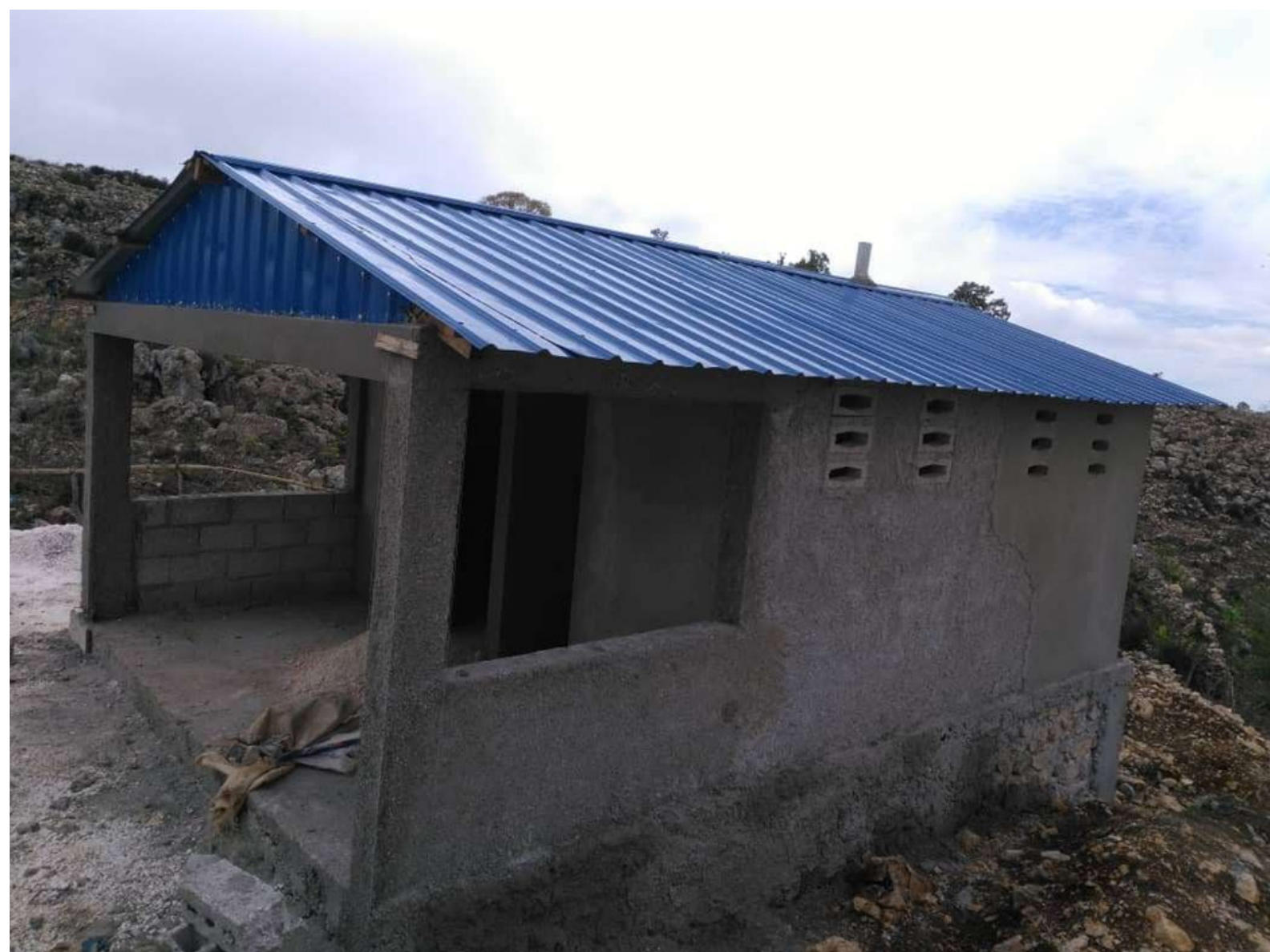
Vue extérieure du bloc sanitaire
