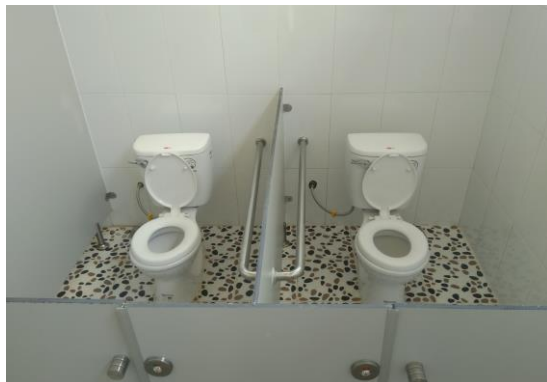
Deux nouvelles toilettes avec chasse d'eau, installées dans une des deux pièces du bloc sanitaire.
