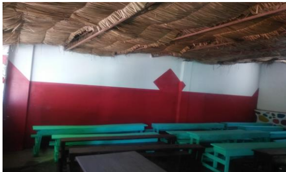
Salle de classe réhabilitée
