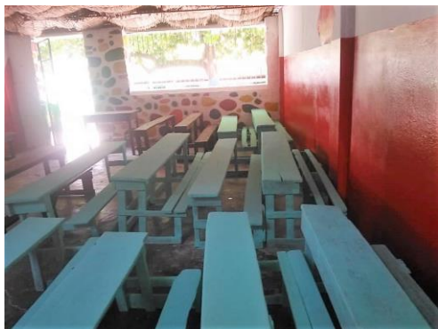
Salle de classe réhabilitée
