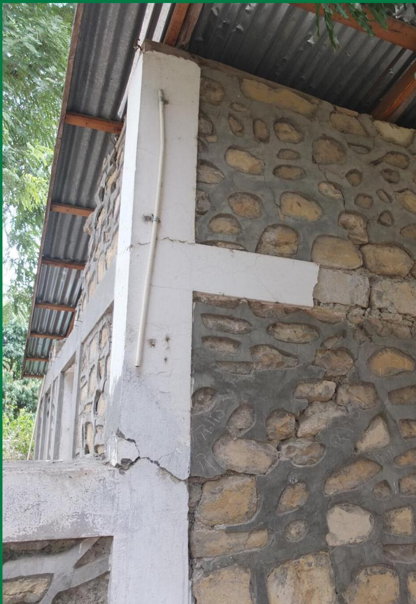
*Colonne extérieure de la salle informatique, dont les fissures et l'absence d'armature métallique en ceinture du bâtiment rendaient possible l'effondrement de la salle en cas de nouvelles secousses*
