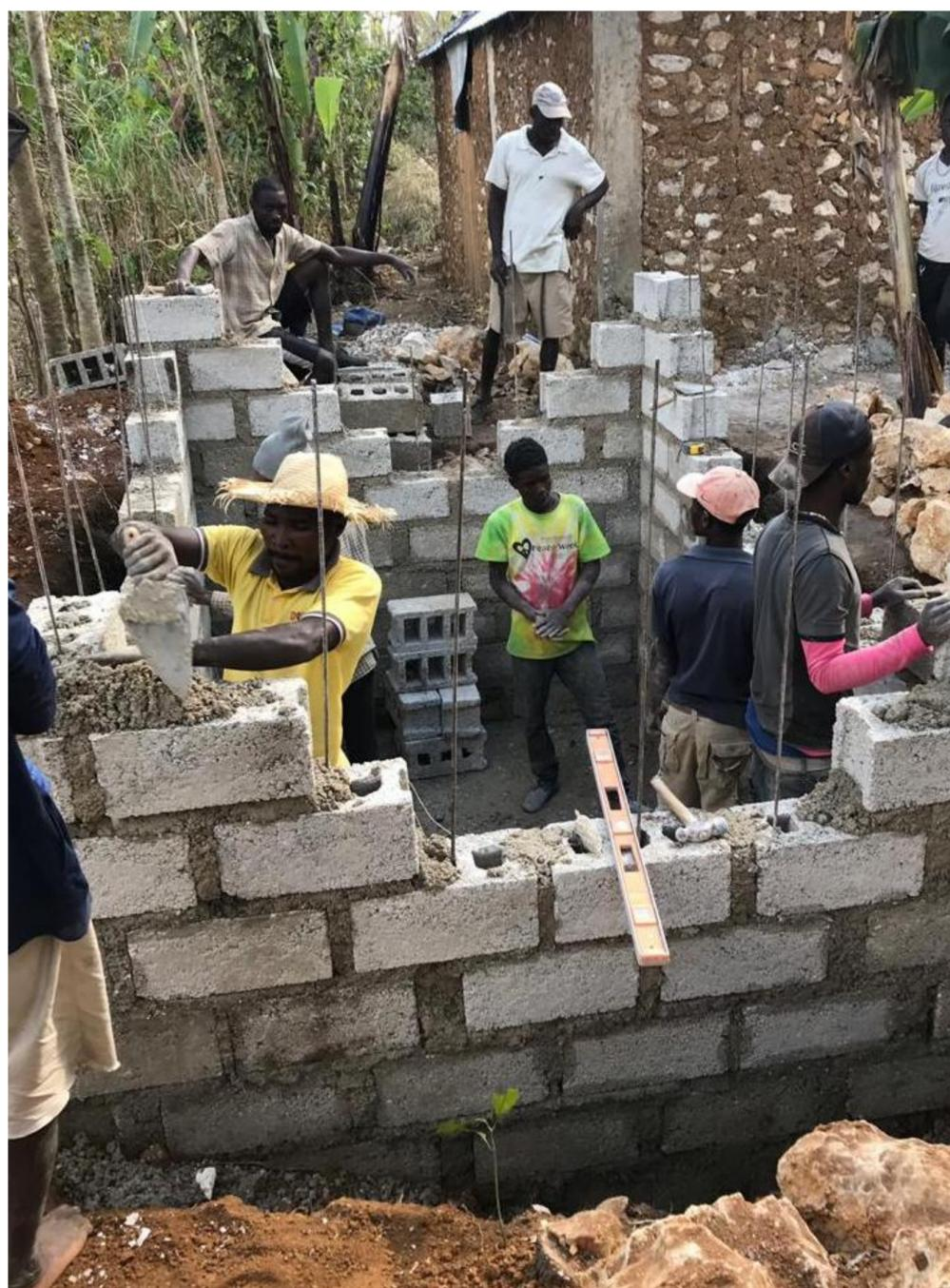
*Pose des blocs de béton par l'équipe en charge de la construction des citernes*
