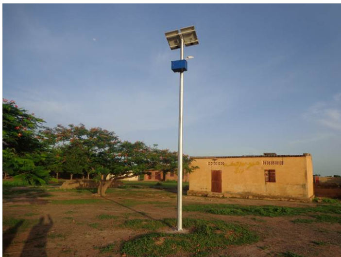
Vu d'ensemble de l'école, avec sur le toit du bureau de la direction, l'un des panneaux solaires.
