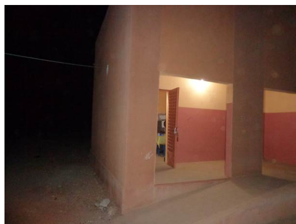
L'entrée et le bureau de la direction électrifiés
