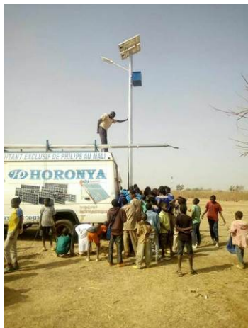
Installation de l'un des lampadaires
