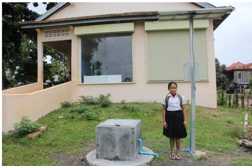
Le forage d'une profondeur de 40m a été relié à une pompe solaire. Elle permet l'approvisionnement en eau de la zone de lavage des mains. L'ensemble est installé dans l'enceinte de l'école.
