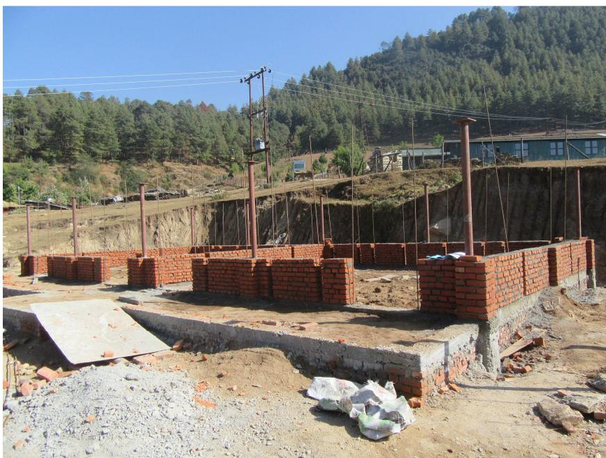
*Après la construction des fondations et la pose de l'armature métallique, les briques ont commencé à être montées sur l'une des écoles.*
