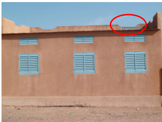
Un panneau solaire (en haut à droite) alimente la savonnerie en électricité
