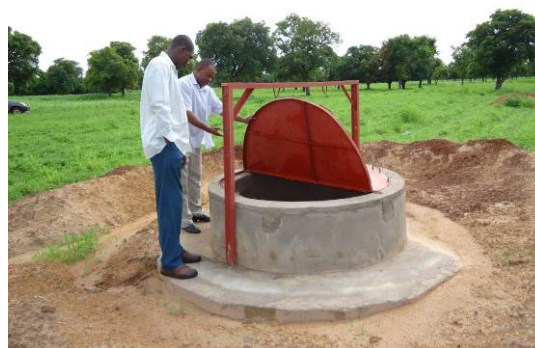
L'équipe de BØRNEfonden Mali entrain de vérifier les installations
